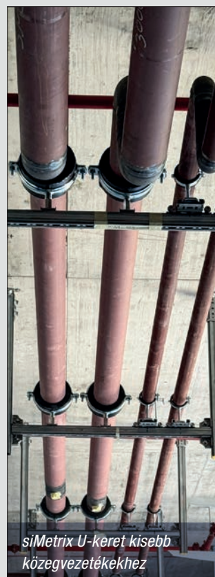
siMetrix közvetlenül az acéltartóhoz csatlakoztatva
