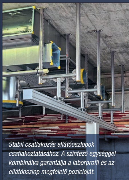
Háromdimenziós rögzítési raszter a nagy telepítési sűrűségű területekhez olyan helyeken, ahol a rugalmasság tekintetében magasak a követelmények.
