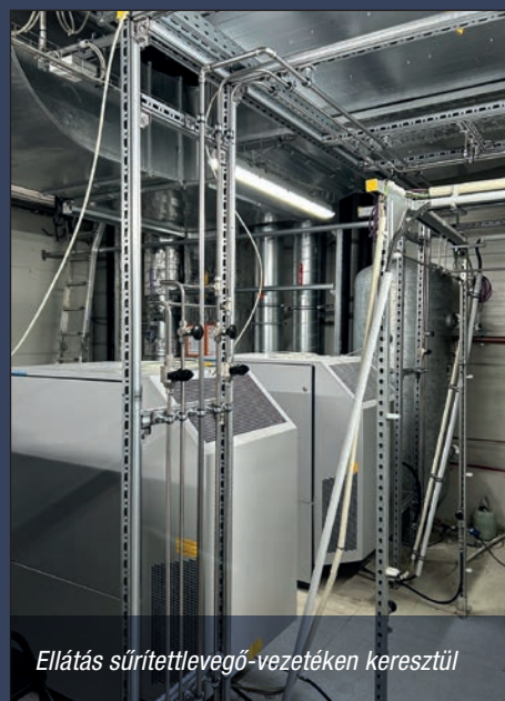
Háromdimenziós rögzítési raszter a nagy telepítési sűrűségű területekhez olyan helyeken, ahol a rugalmasság tekintetében magasak a követelmények.
