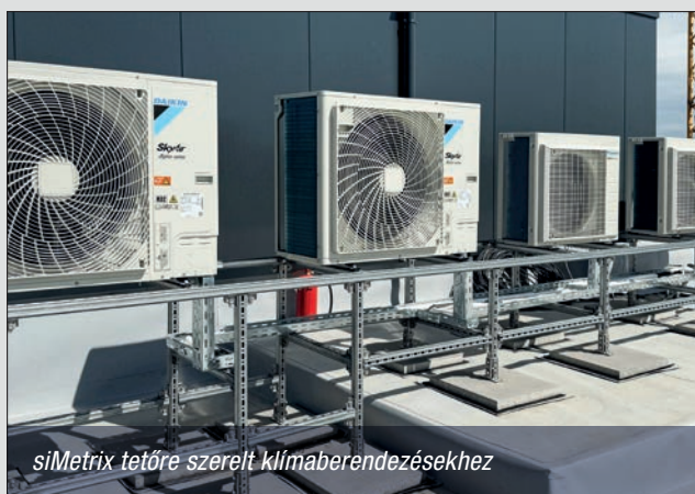
siMetrix közvetlenül az acéltartóhoz csatlakoztatva
